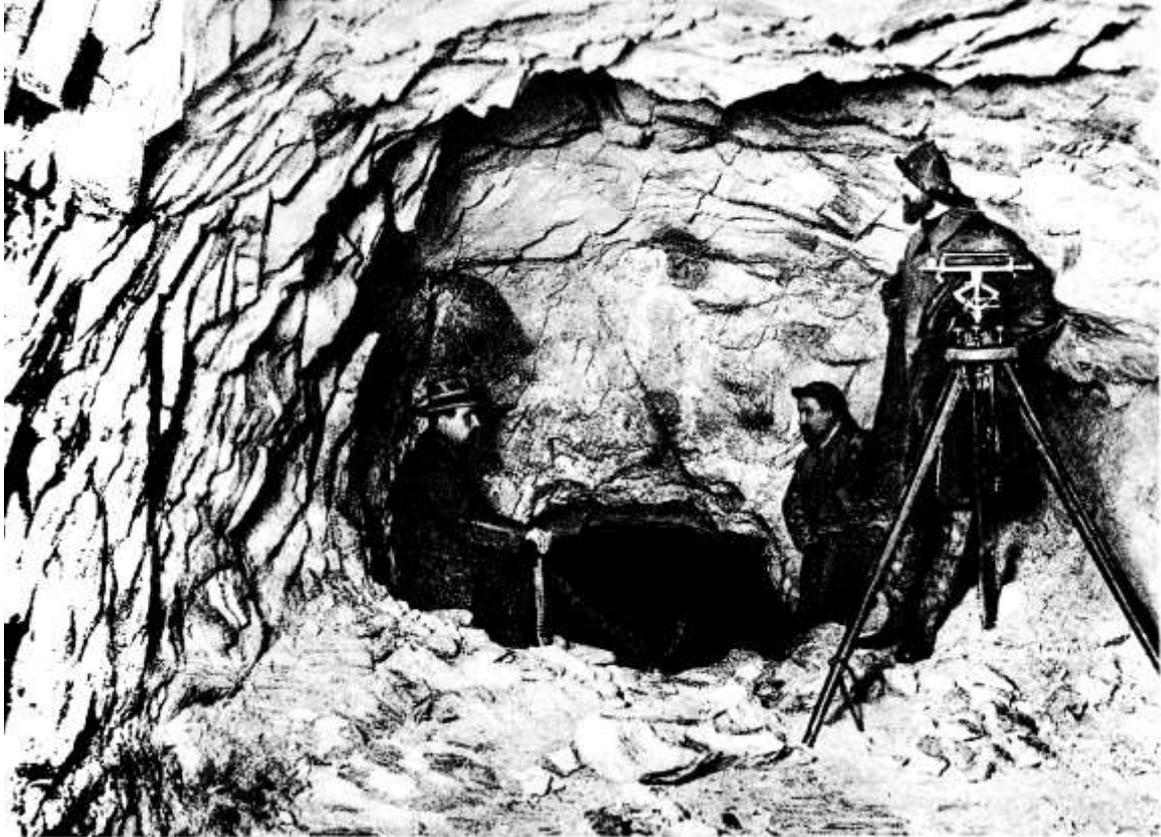
Durchschlag des Albulatunnels am 29. Mai 1902. Ingenieure posieren im engen Loch. Aufgestellt ist auch ein Theodolit, das unabdingbare Vermessungsinstrument beim Tunnelbau. Zeitgen. Fotografie aus: Pfeiffer (2003), S. 113.
